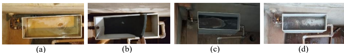
Fig. 2 - Filtro primário, montagem e uso diário: a) reservatório de recepção do esgoto cinza; b) colocação mantas (Scotch-Brite F550); c) uma semana de uso; d) duas semanas de uso.
